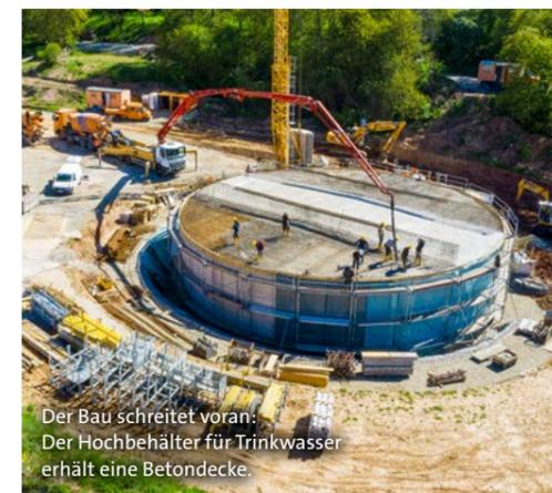
Der Bau schreitet voran: Der Hochbehälter für Trinkwasser erhält eine Betondecke.
