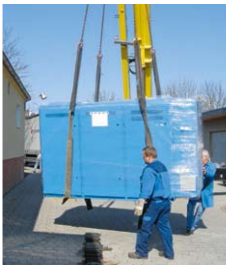
Energieleistung: Das neue Blockheizkraftwerk wurde im März mit einem Lastkran beim St. Johannesstift in Ershausen angeliefert.
