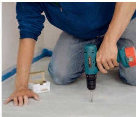
Nach dem Entfernen von überschüssigem Kleber den verklebten Stufenfalz verschrauben.
