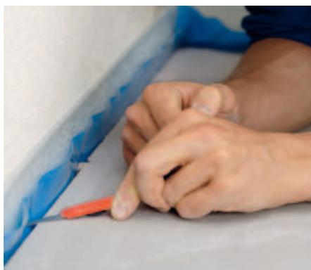
Zum Schluss Folie und Randdämmstreifen abschneiden – dann kann der Bodenbelag folgen.
