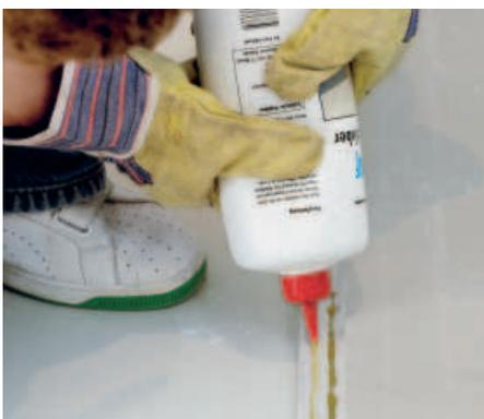
Beim Aufbau des Estrichbodens zuerst den Stufenfalz gut verkleben.
