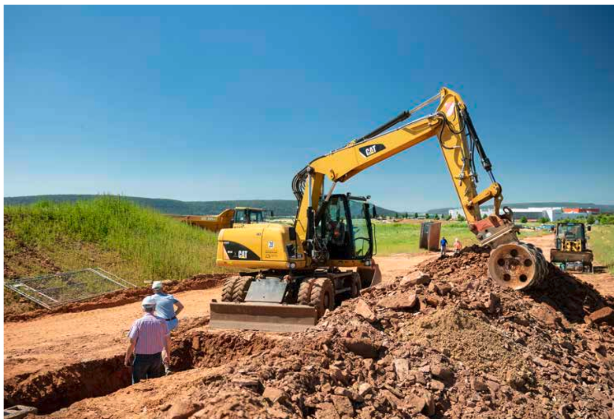
Rund 240.000 Kubikmeter Erde mussten auf dem Areal umgeschichtet werden.
