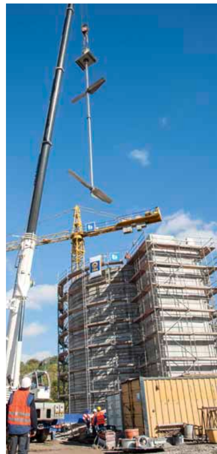
Das 1,2 Tonnen schwere Rührwerk wurde erst vor Ort montiert und durch die schmale Öffnung des Faulturms manövriert.
