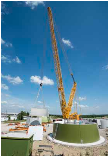
Präzisionsarbeit für die Spezialisten und Schwerstarbeit fürs Gerät: Mit einem Spezialkran werden die Elemente in luftige Höhe gehievt und dann montiert.
